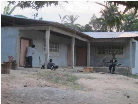
Färdigställande pågår av en ny skolbyggnad i Benla
